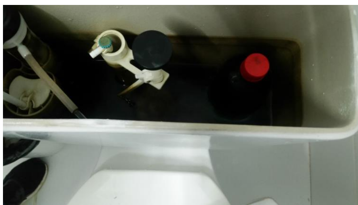
Imagem 2 – Instalação da garrafa na caixa acoplada
