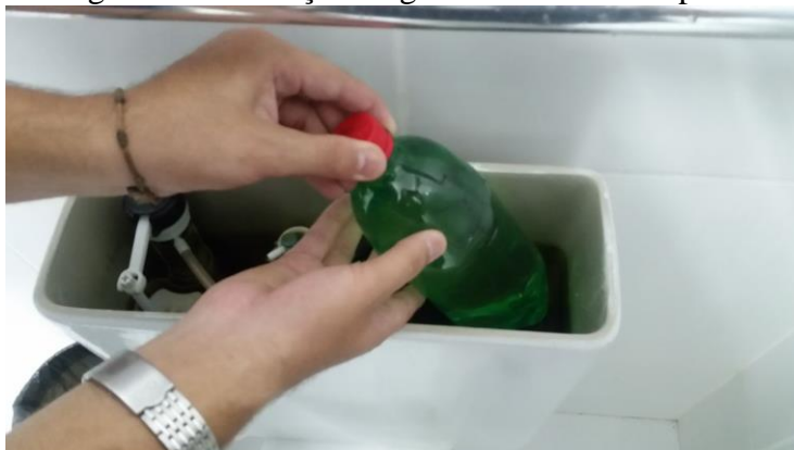
Imagem 1 – Instalação da garrafa na caixa acoplada
