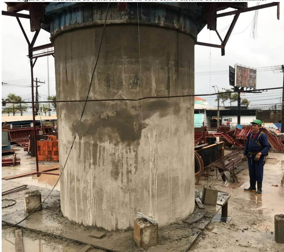
Figura 1 – Estrutura de concreto feita na obra com o sistema de fôrma deslizante.
