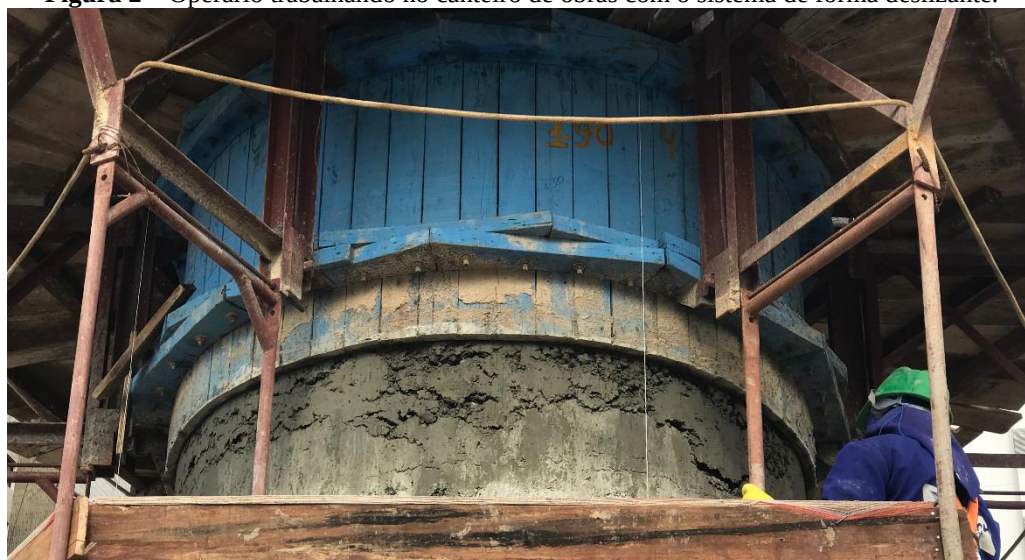
Figura 2 – Operário trabalhando no canteiro de obras com o sistema de fôrma deslizante.
